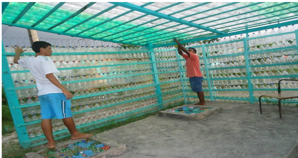
Fotografia 2- construção da casa verde com garrafa PET.
