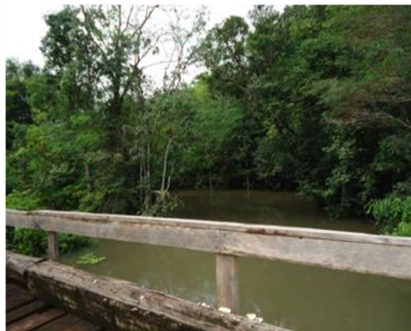
Figura 10: Ponte sobre o Rio Jambuaçu.
