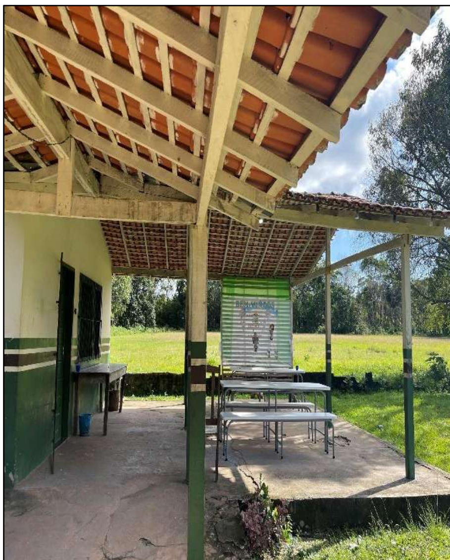
Figura 36 - Refeitório e cozinha
