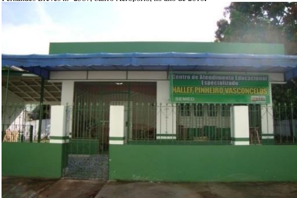
Imagem 5 – Faixada do CAEE Hallel Pinheiro Vasconcelos, com localização na Rua Ângelo Fernandes Breves n.º 2387, bairro Aeroporto, no ano de 2010.
