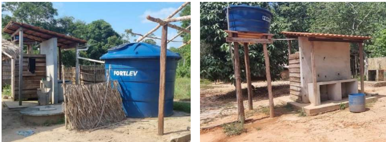
Imagem 1 – Construção de banheiro, lavanderia e caixa d'água
