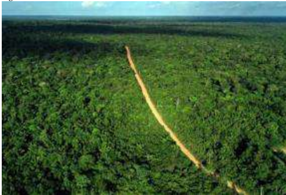
Figura 7: Vista aérea da BR-422.
