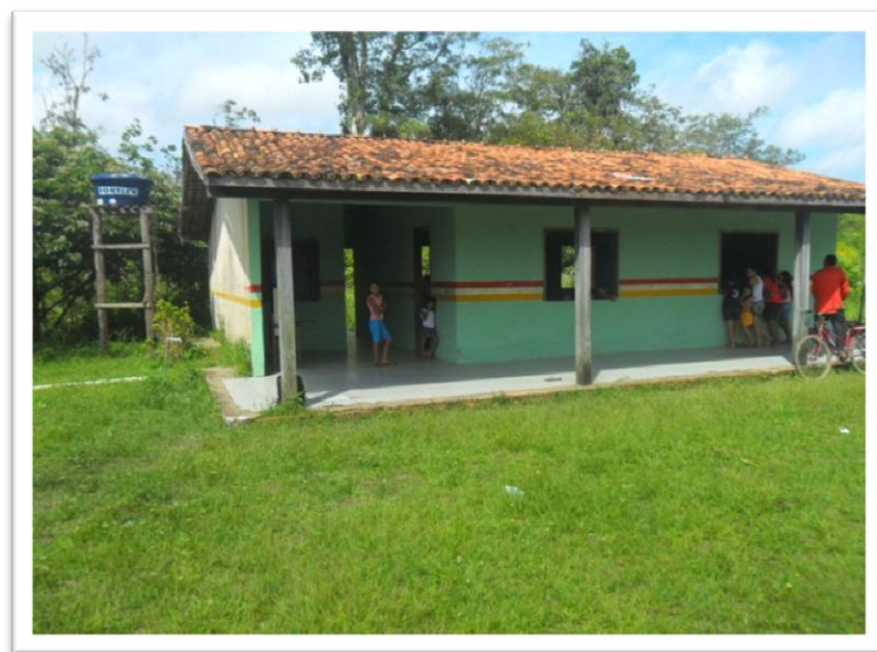
Figura 21 : Escola situada em comunidade de terra firme. Fonte: Arquivo de técnicos da SEMED, 2012.
