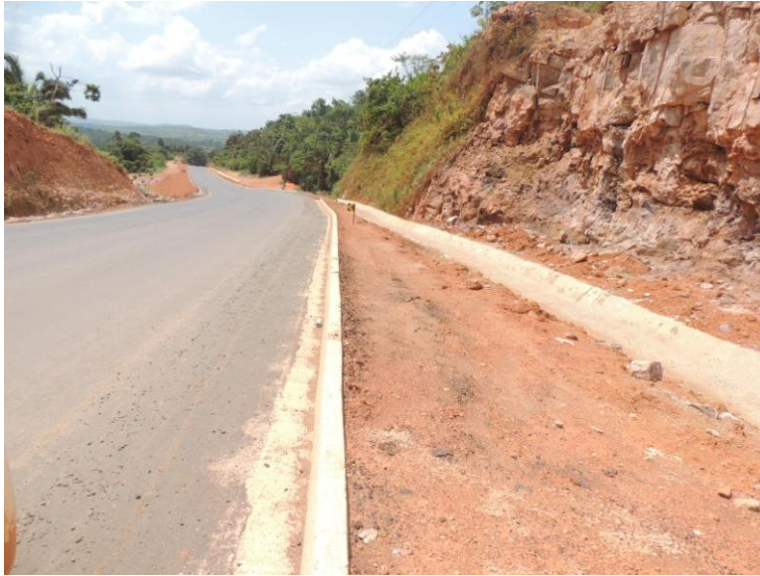
Imagem 3: Trecho pavimentado da Rodovia BR-230 Fonte: www.rodoviasevias.com.br
