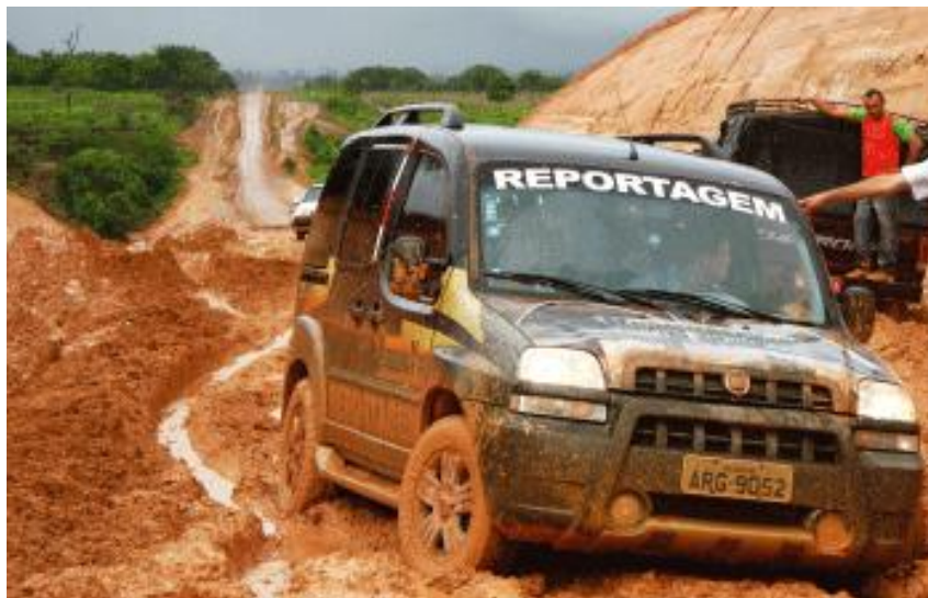
Imagem 02: Trecho da Rodovia BR-230 antes da pavimentação Fonte: www.rodoviasevias.com.br
